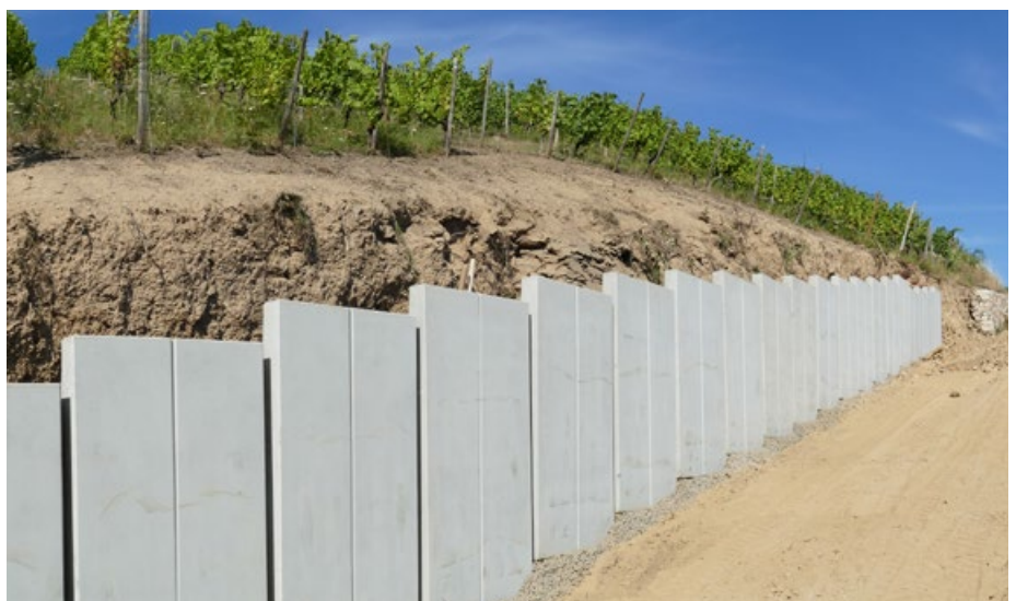
Abb. 2: Eltville-Martinsthal: Hangsicherung durch Errichtung von Stützwinkeln vor Trockenmaueraufbau im Sanierungsbereich (Foto: LPV Rheingau-Taunus)
